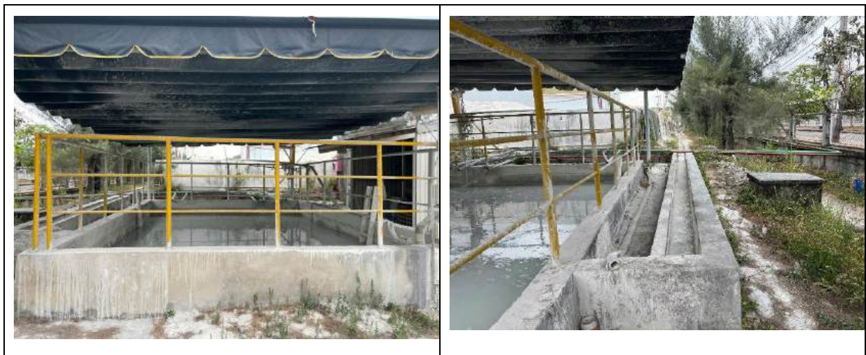
Hình 3. 4. Hình ảnh hệ thống nước thải tại cơ sở
